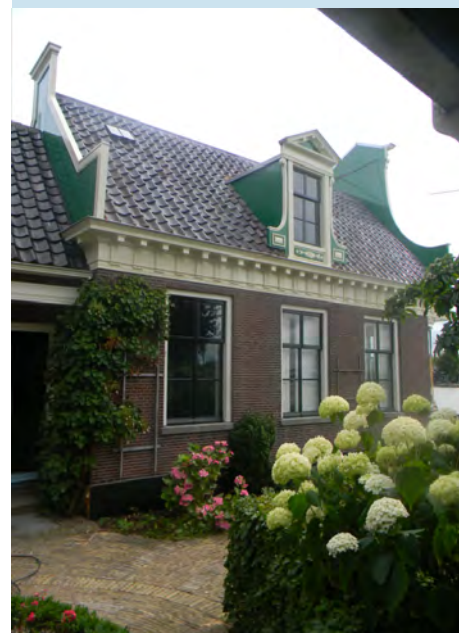
Het luchthuis na de succesvolle renovatie
