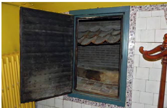
Het rookluik in de schoorsteen bij de bodekamer en een blik omhoog in het gerestaureerde rookkanaal
