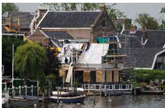
De Zankamer werd van een nieuwe kap voorzien
