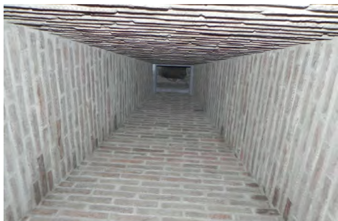
Het rookluik in de schoorsteen bij de bodekamer en een blik omhoog in het gerestaureerde rookkanaal
