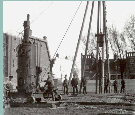
Heiwerkzaamheden voor de bouw van de Christelijke School met de Bijbel, Stationstraat Koog-Zaandijk, 1914 Op de plaats van deze school stond voorheen papiermolen "De Zwarte Bonsem" van de firma Jan Kool & Comp. [Foto: P. Nieuwstad, Koog aan de Zaan; ZOV, GAZ 21.01260]
