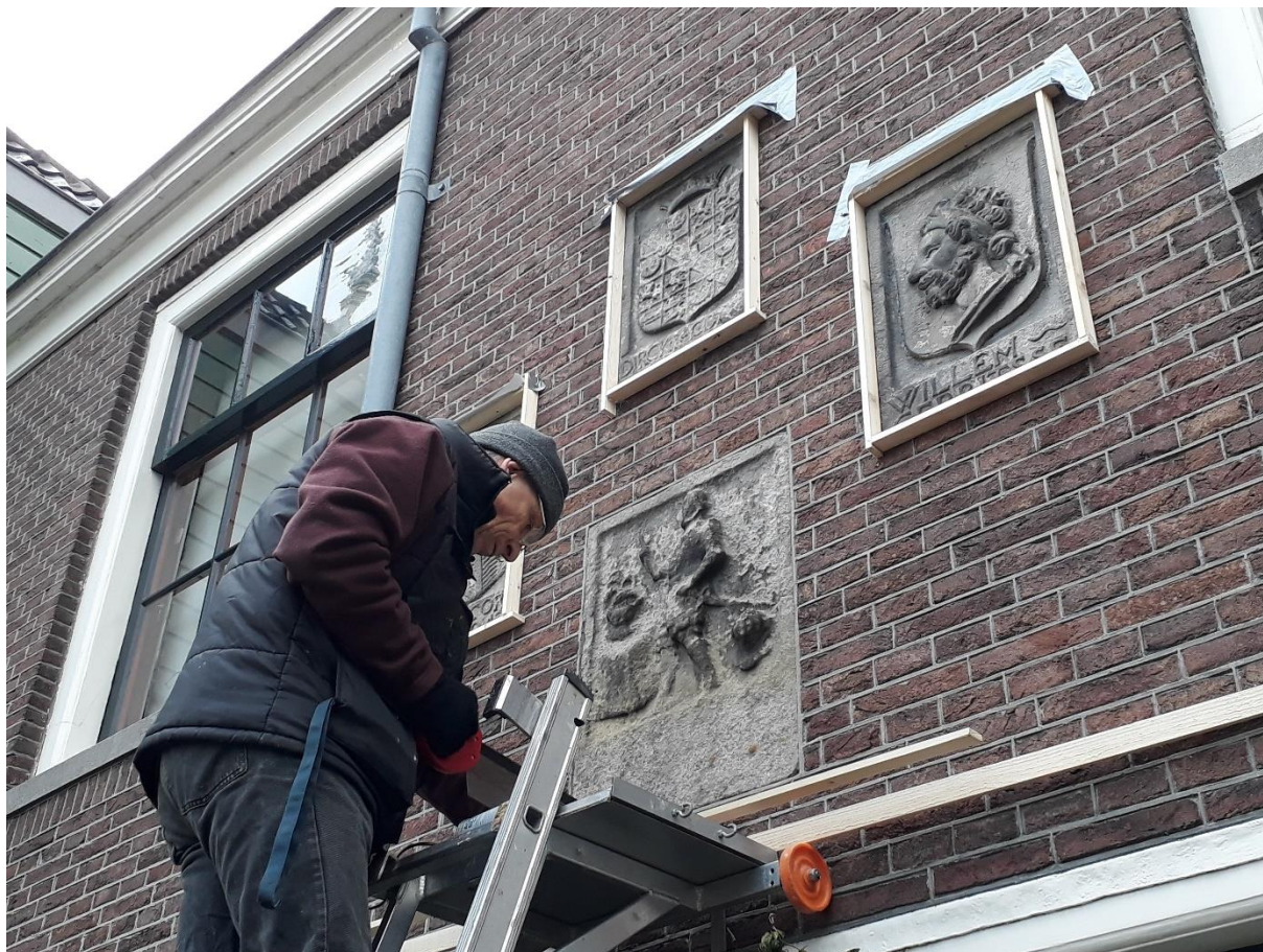
De restaurator bereidt het afnemen voor van de siliconen mallen, benodigd voor de afgietsels van de 17 de eeuwse gevelstenen, afkomstig van de Beschuitstoren. [Foto Wietske van Soest]
