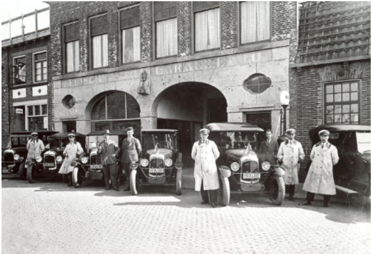
Gevel van de Leidsche Autogarage LATO, naar ontwerp van architect H.J. Jesse (1860–1943), ca. 1930.
